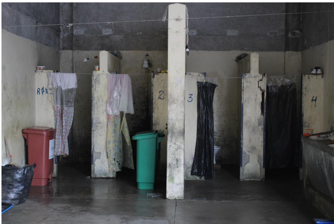
Banheiros e chuveiros comuns no pátio do raio
