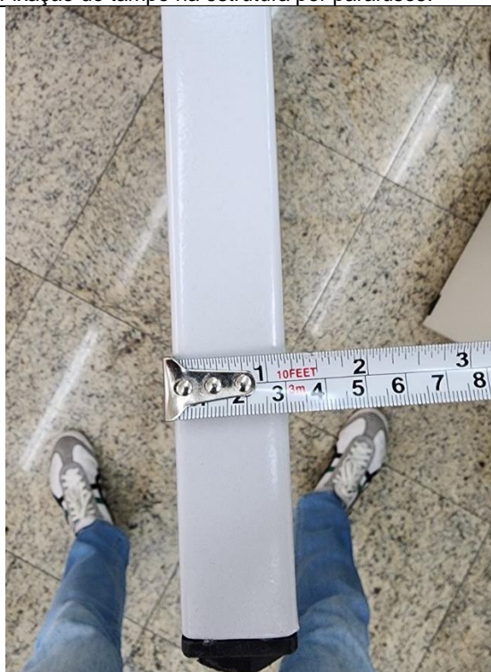
Estrutura formada por tubos de aço carbono de seção retangular 40 x 30 mm.
