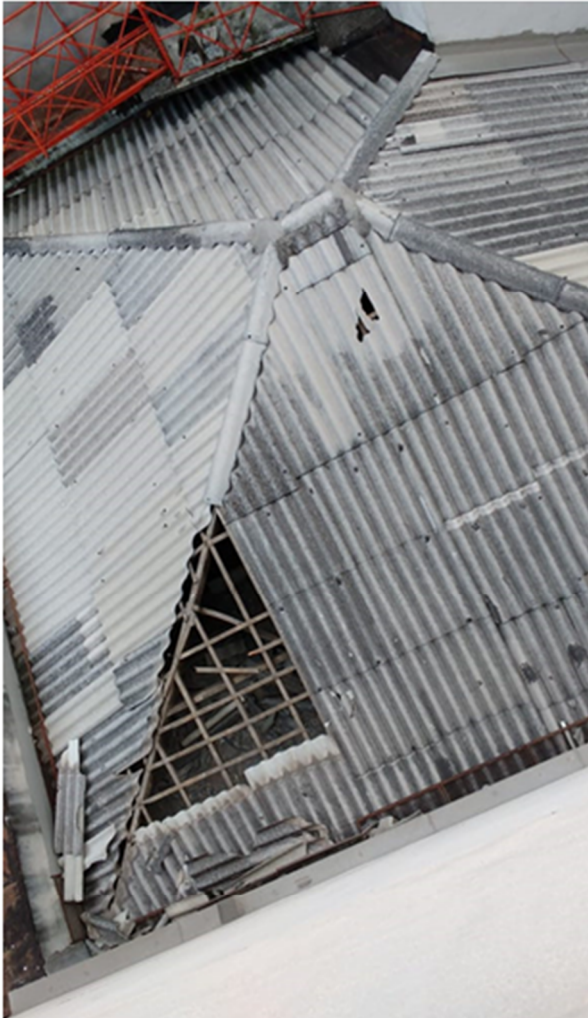
Foto 05 - Vista da cobertura sobre o 8º andar. O telhado original foi substituído por telhas de fibrocimento onduladas que estão envelhecidas e com remendos. Situação registrada antes dos reparos pontuais e da instalação da manta aluminizada
