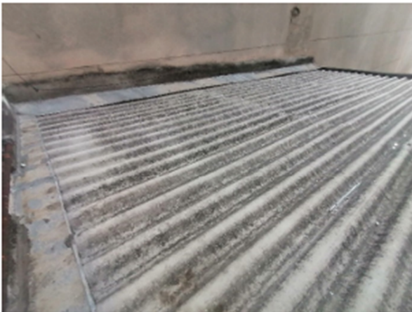
Foto 03 - Vista da cobertura sobre o 3º andar. O telhado apresenta telhas onduladas de fibrocimento. Identificados remendos junto aos rufos
