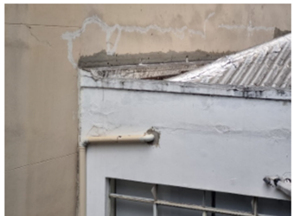
Foto 12 – Instalação de um condutor vertical de água pluvial adicional
