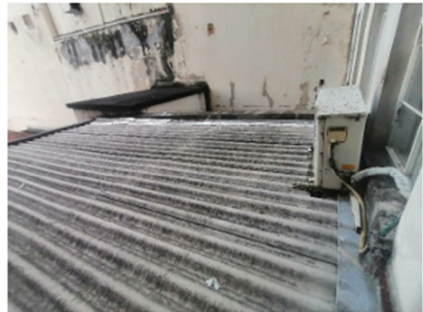
Foto 04 - Vista da cobertura sobre o 3º andar. O telhado apresenta telhas onduladas de fibrocimento. Identificados remendos junto aos rufos
