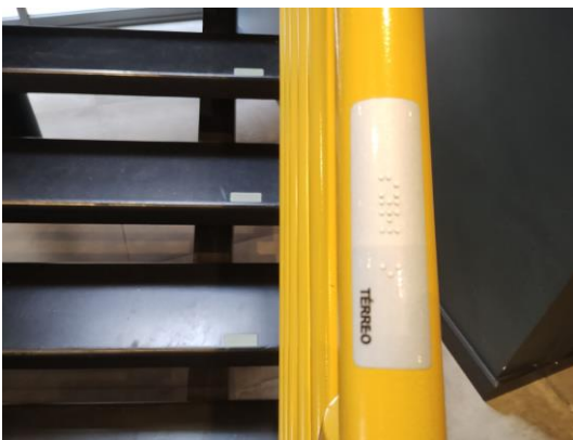
Foto 05 – Sinalização em braille no corrimão
