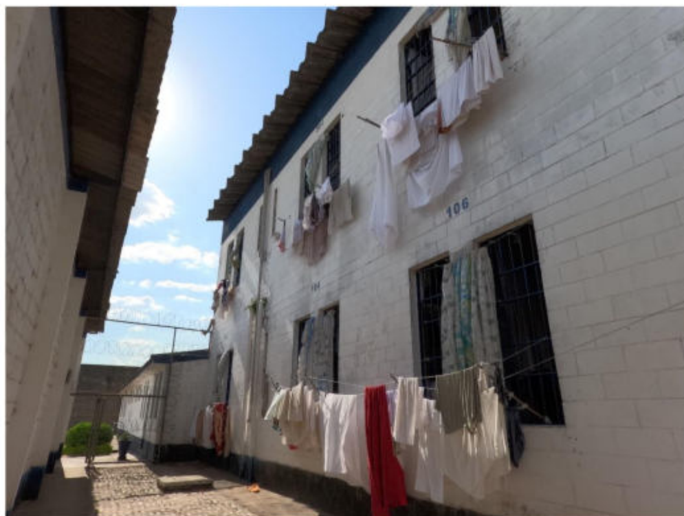
Foto das janelas das celas vistas da área externa
