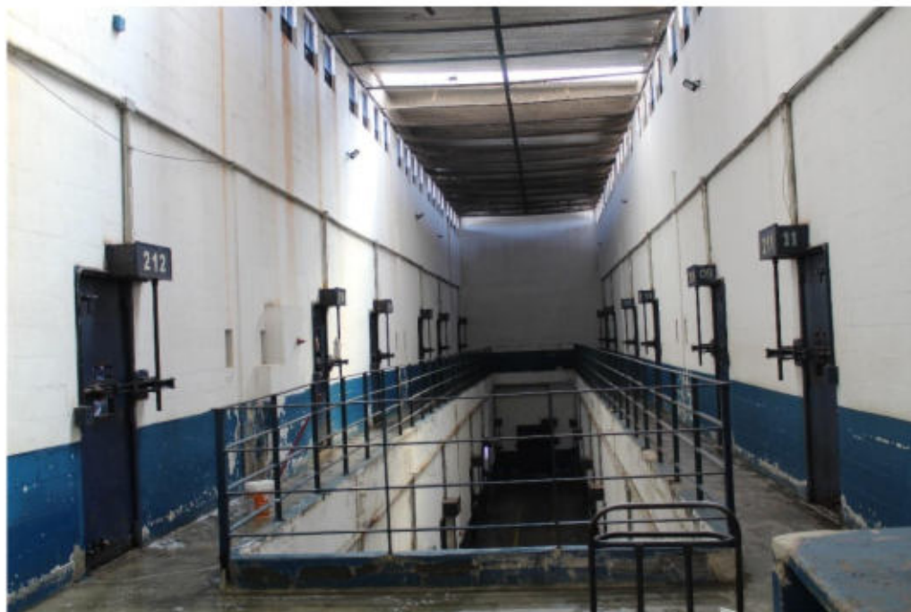
Destaque para as celas do segundo andar de um dos pavilhões
