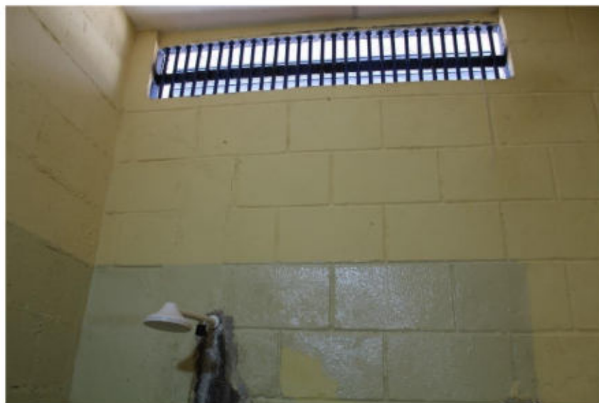
Entrada de ar localizada nos fundos da cela
