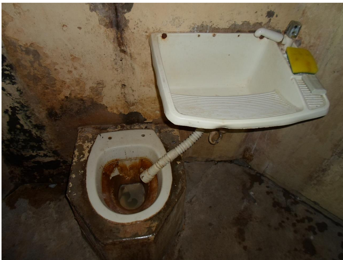
(condições do sanitário do castigo)
