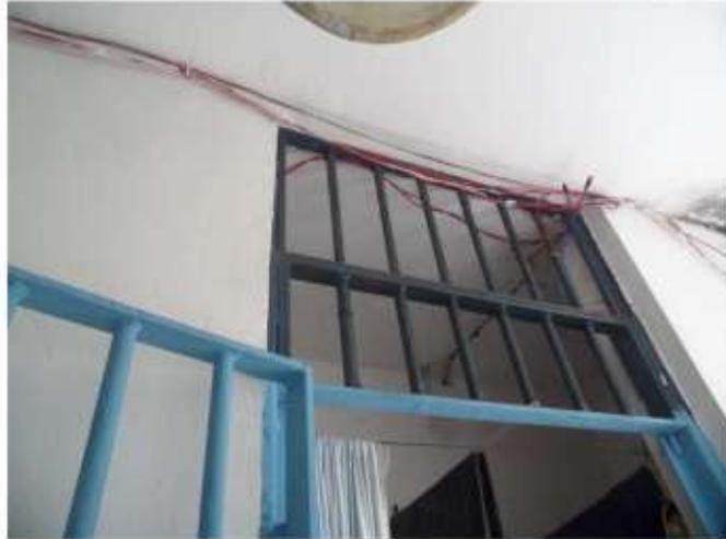
O setor possui fiação elétrica exposta e precária, gerando evidente risco de incêndio e de choque elétrico.
