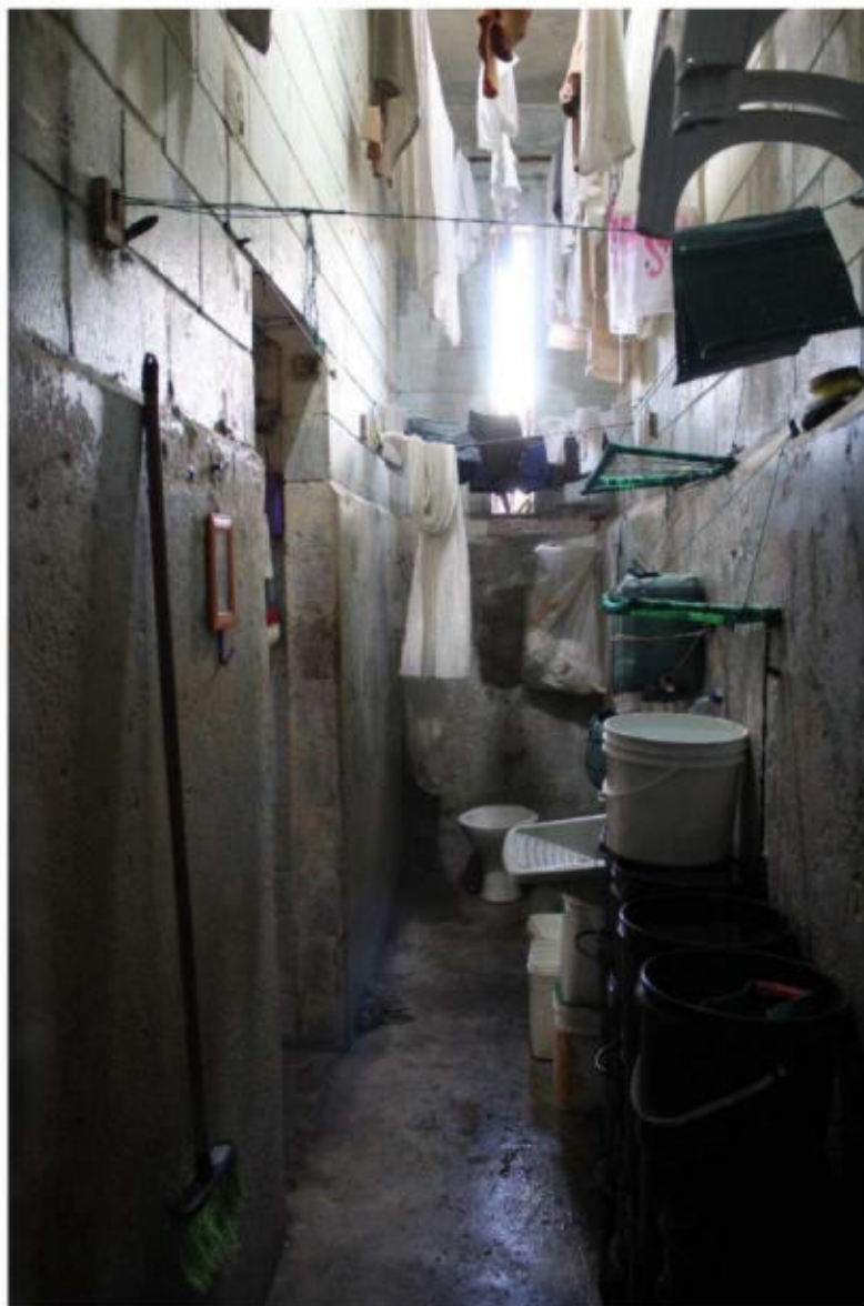
Foto interna do corredor do banheiro de uma das celas do convívio
