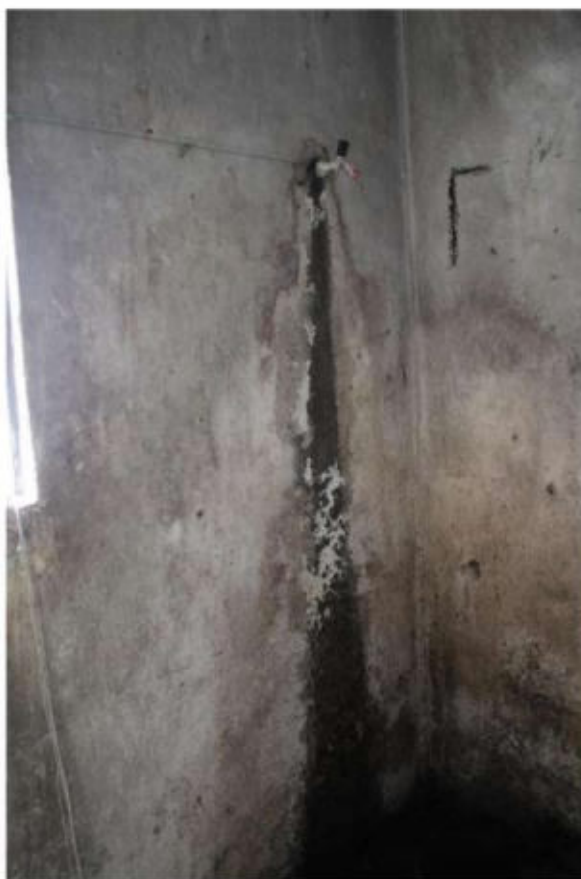
Detalhe para a ausência de chuveiro em uma das celas
