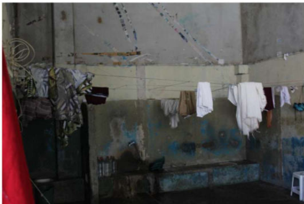
Banheiro do Pavilhão 8
