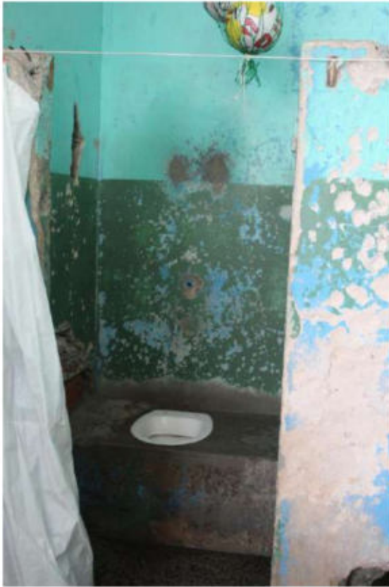
(Banheiro de uma das celas).
