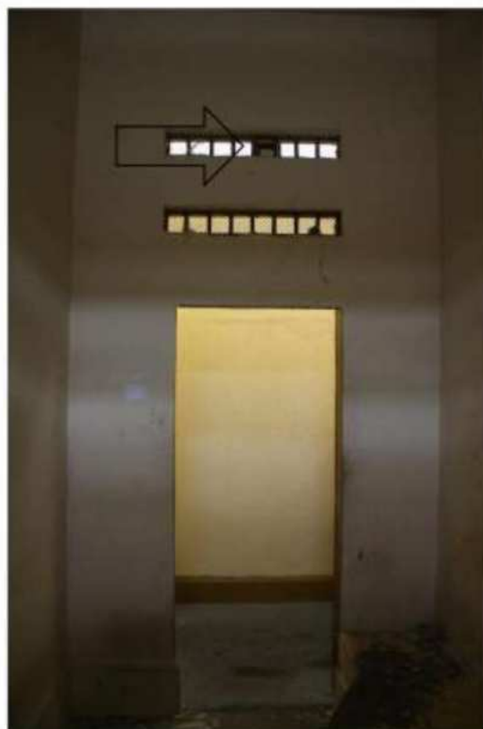
Detalhe para a única iluminação artificial da cela controlada apenas pelos agentes
