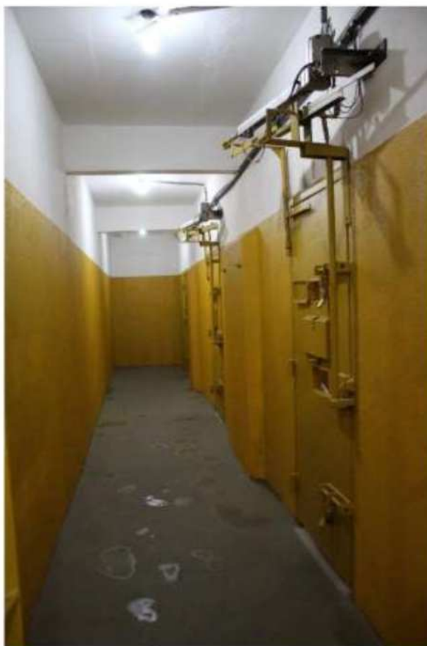
Corredor de acesso às celas do setor de inclusão / prisão temporária
