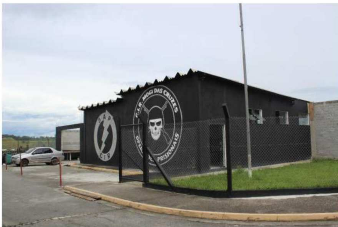
Base do C.I.R. na área externa da unidade
