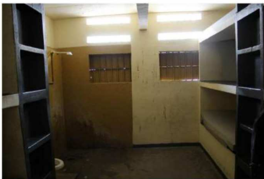
Cela ocupada por um preso no setor de inclusão
