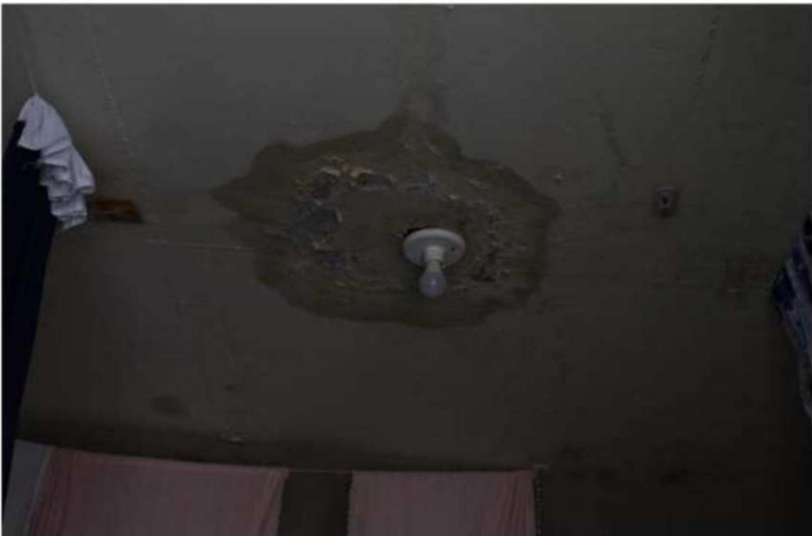
(foto do interior de uma cela mostrando diversos pontos de infiltração)
