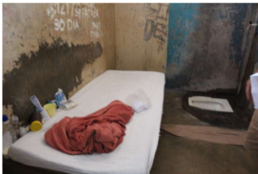
Fotografia 11: Cella do Pavilhão Disciplinar
