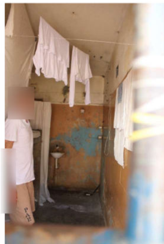
Fotografia 27: Cella do pavilhão 07
