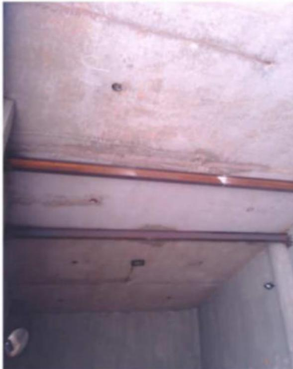
**Foto de rachadura na parte externa do pátio do raio cinco, demonstrando infiltrações e um reparo aparentemente insuficiente.**
